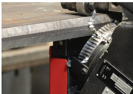
Smussatura del lato inferiore di lastre
