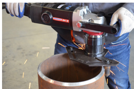
Anfasen von Rohren
