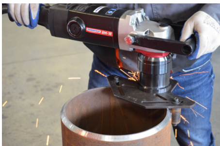
Biselado de tubería
