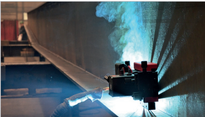
Welding edge to edge
