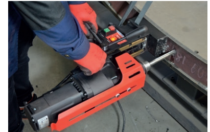
Perforación fuera de posición
