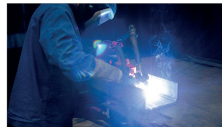
Saldatura in spazi ristretti (larghezza minima 200 mm)
